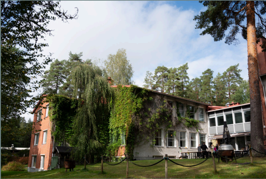
Päärakennus takapihalta katsottuna
